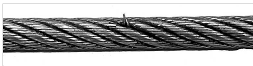
Rotura de alambre con alambre saliente.
