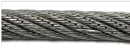
Varias roturas de alambres. La rotura de alambres es síntoma del desgaste normal del cable. Se producen cuando el cable se flexiona en las poleas bajo carga.
