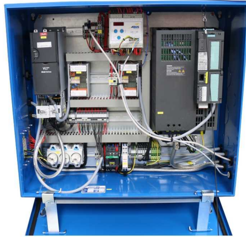
ABUS Electric 3 con convertidor de frecuencia ABULiner traslación y/o elevación
